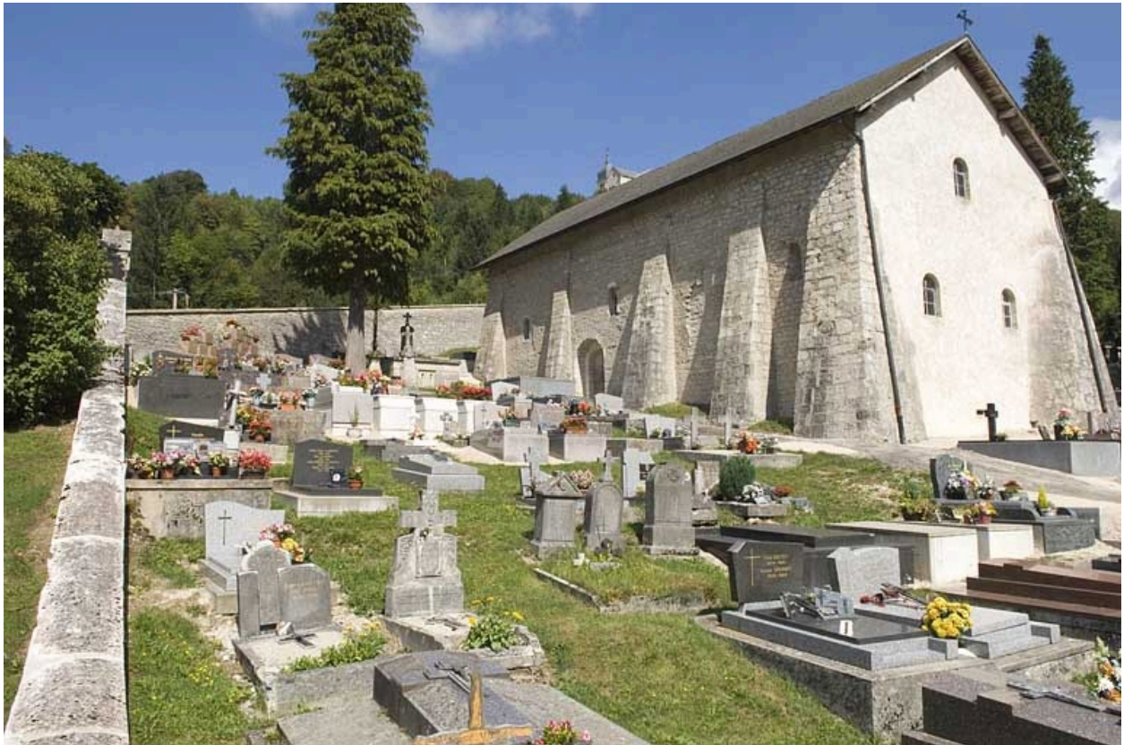
Le cimetière, vu du sud-ouest.
