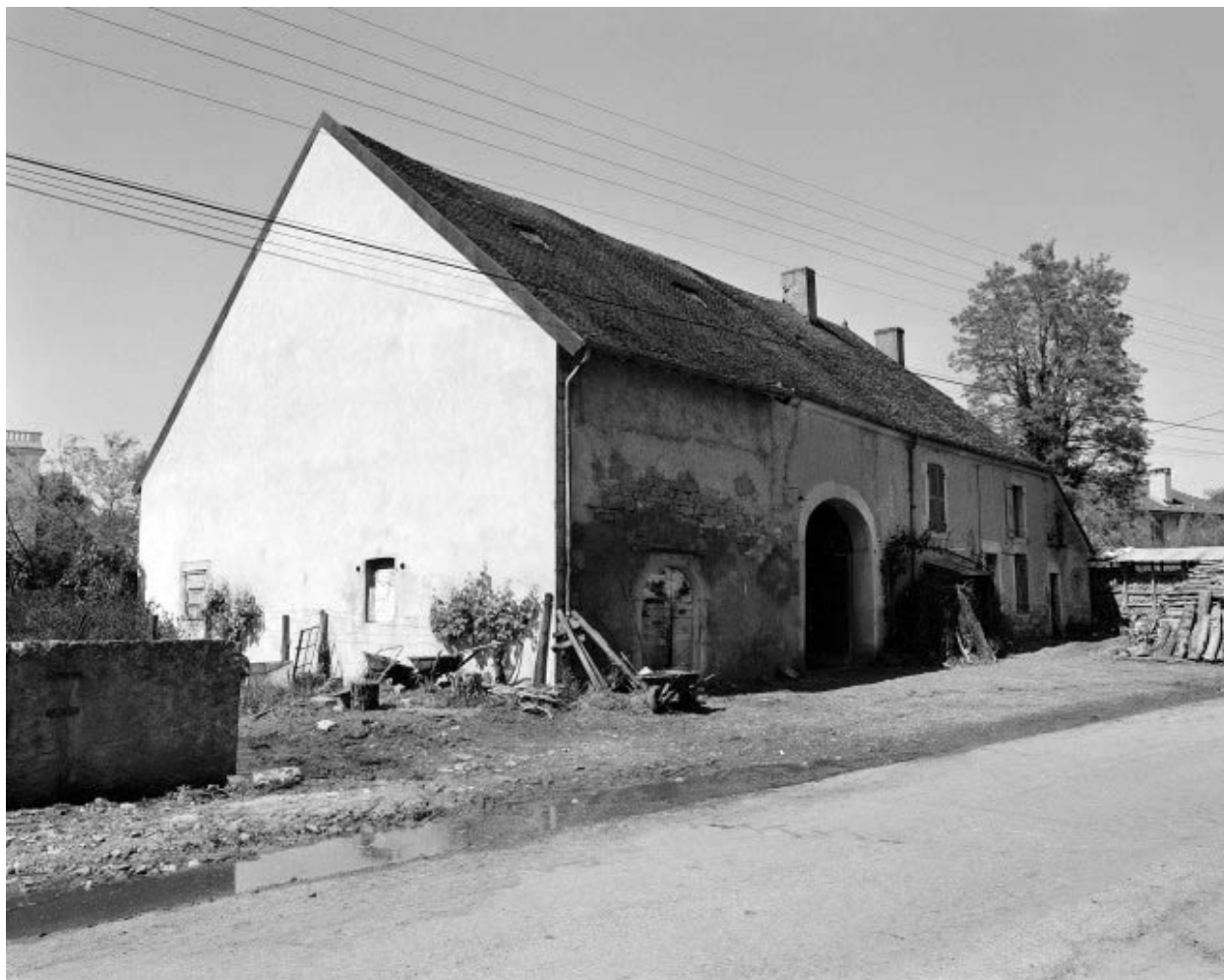
Ferme située rue Neuve : façade antérieure.
