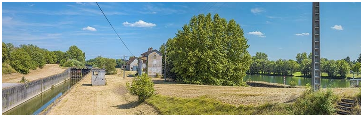
Vue d'ensemble du site d'écluse depuis l'aval.
