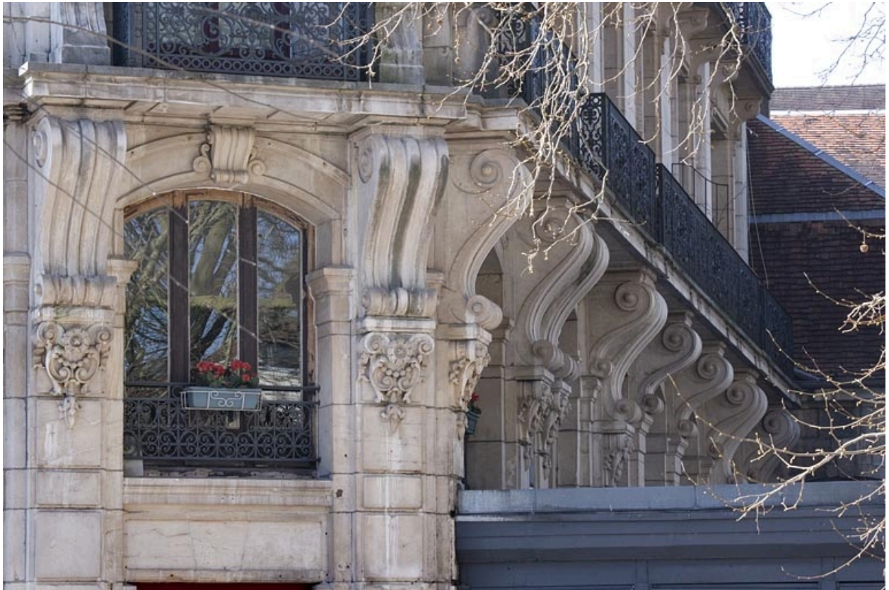
Détail des consoles soutenant le balcon filant.
