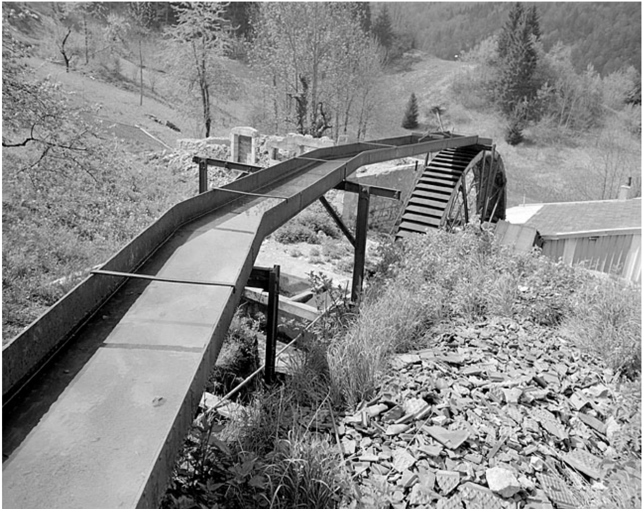
Canal d'amenée métallique et roue hydraulique.
