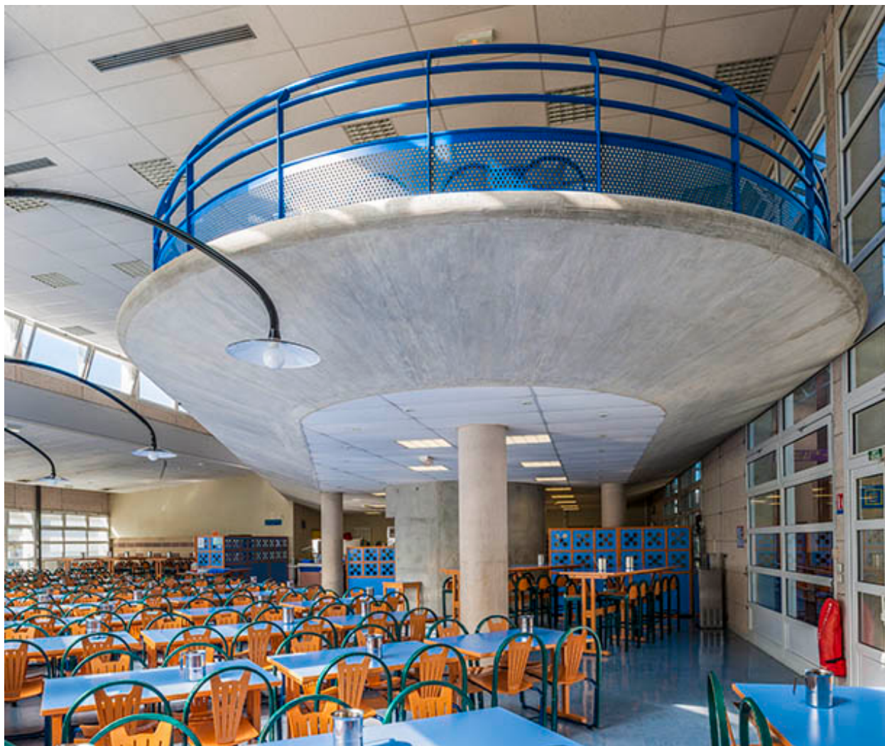
Restauration : salle rez-de-chaussée et mezzanine.
