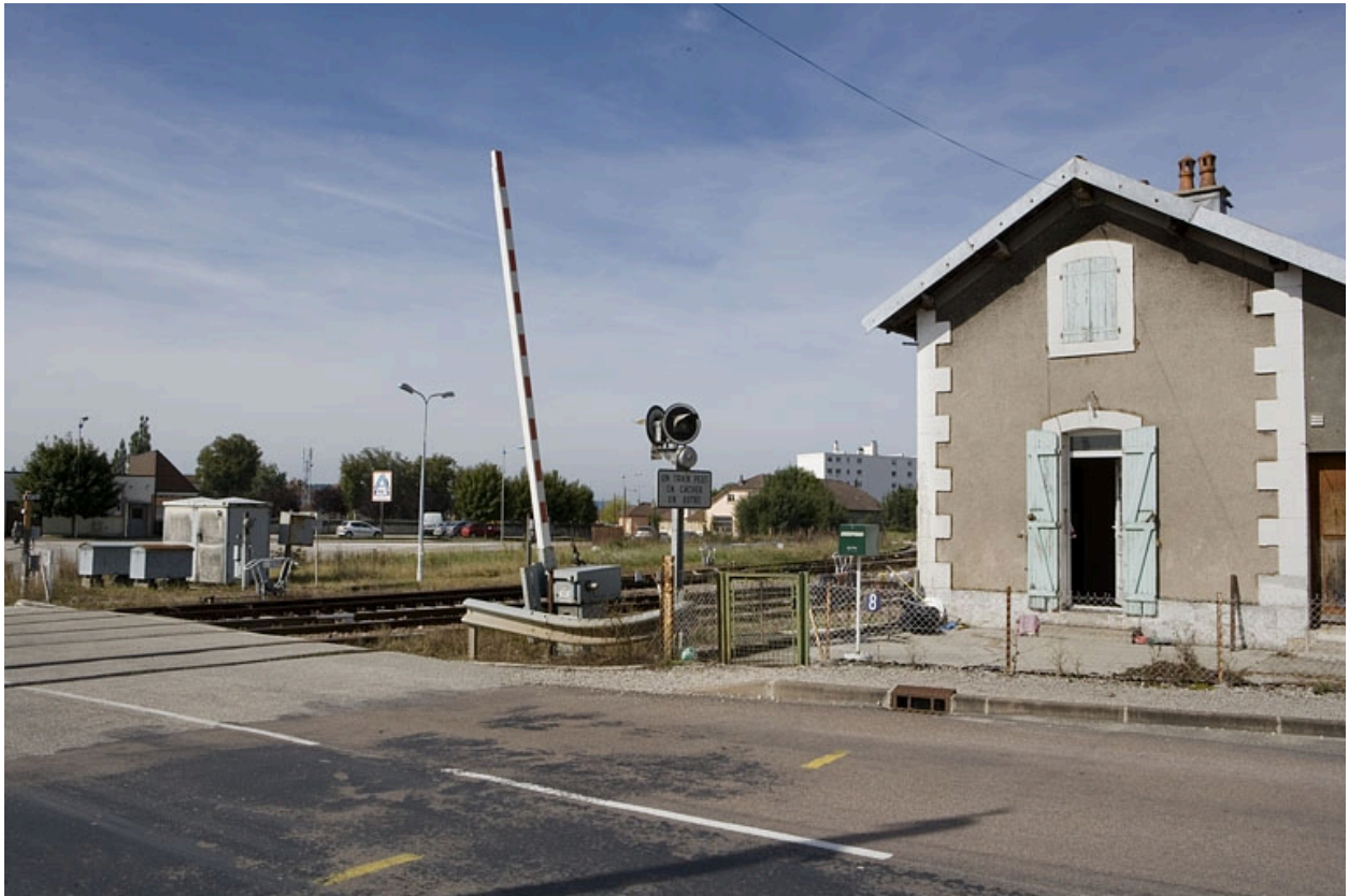
Vue d'ensemble de la barrière côté Mont Rivel.
