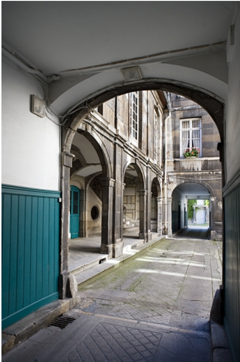
Détail de l'aile droite contenant l'escalier depuis le passage cocher du logis principal.
