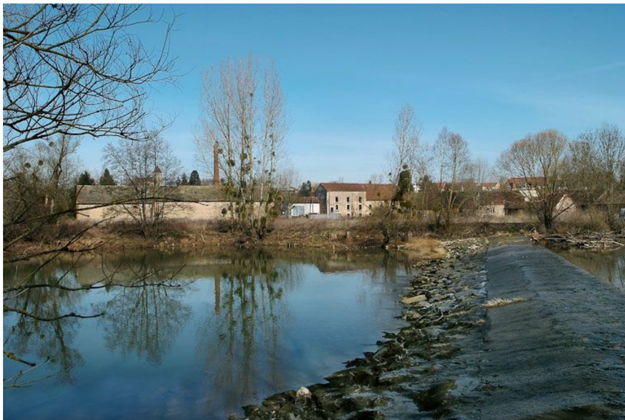
Barrage lié aux moulins de Branges.
