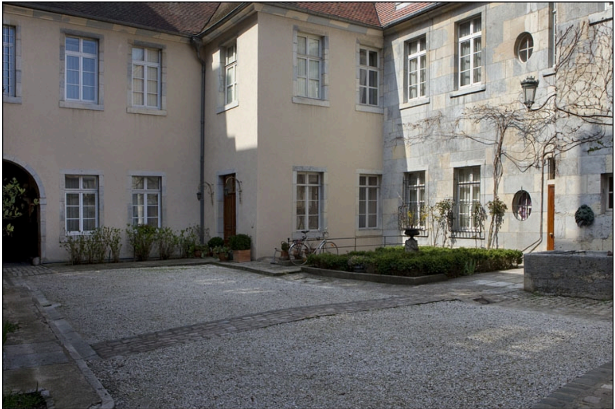
Vue d'ensemble de l'angle entre l'aile sur cour et la façade postérieure du logis principal.
