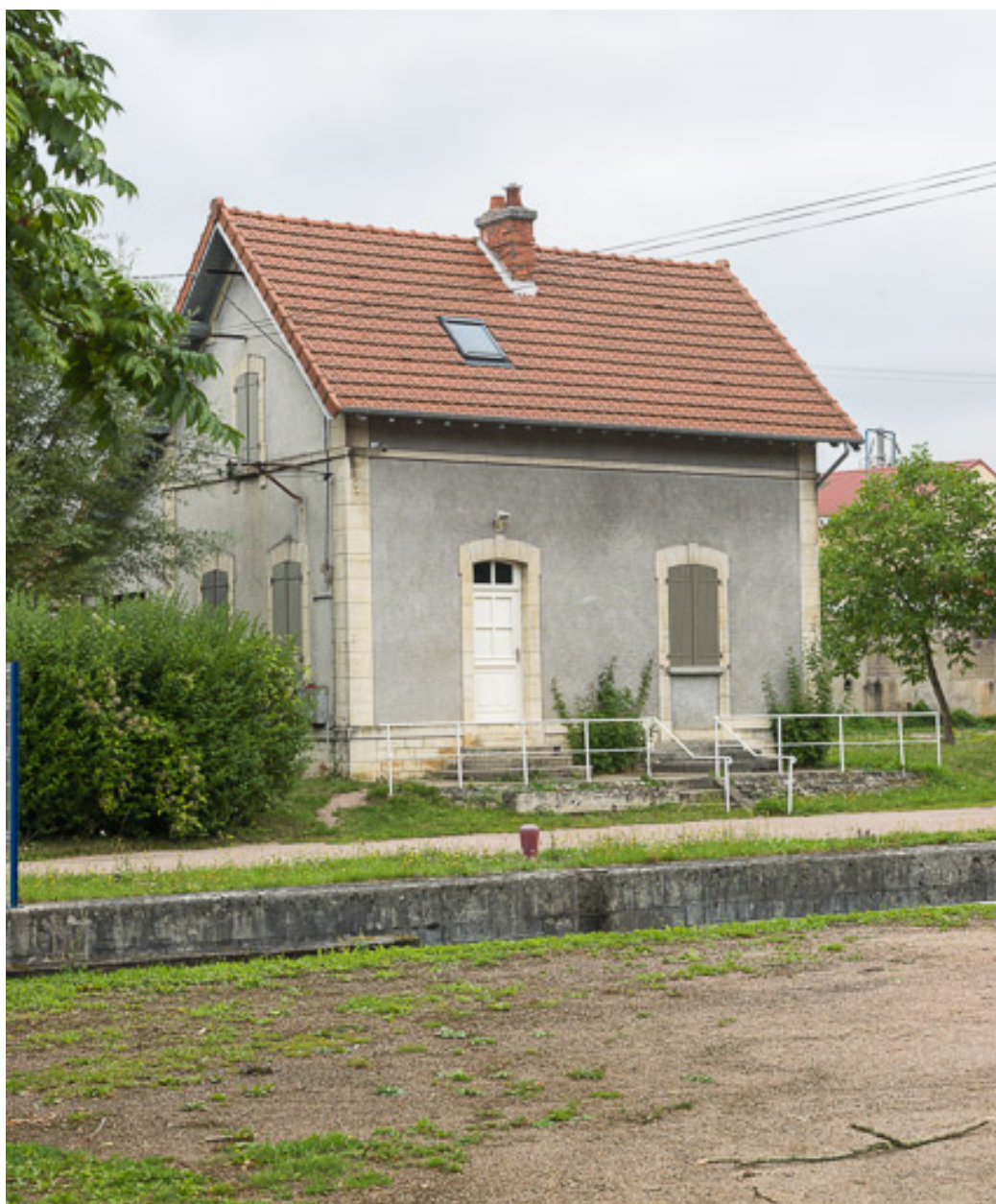
Vue de la maison éclusière.
