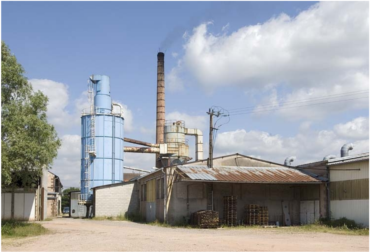
Silo et cheminée. Vue d'ensemble.
