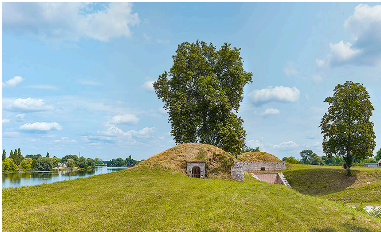
Casemates sur le terre-plein.
