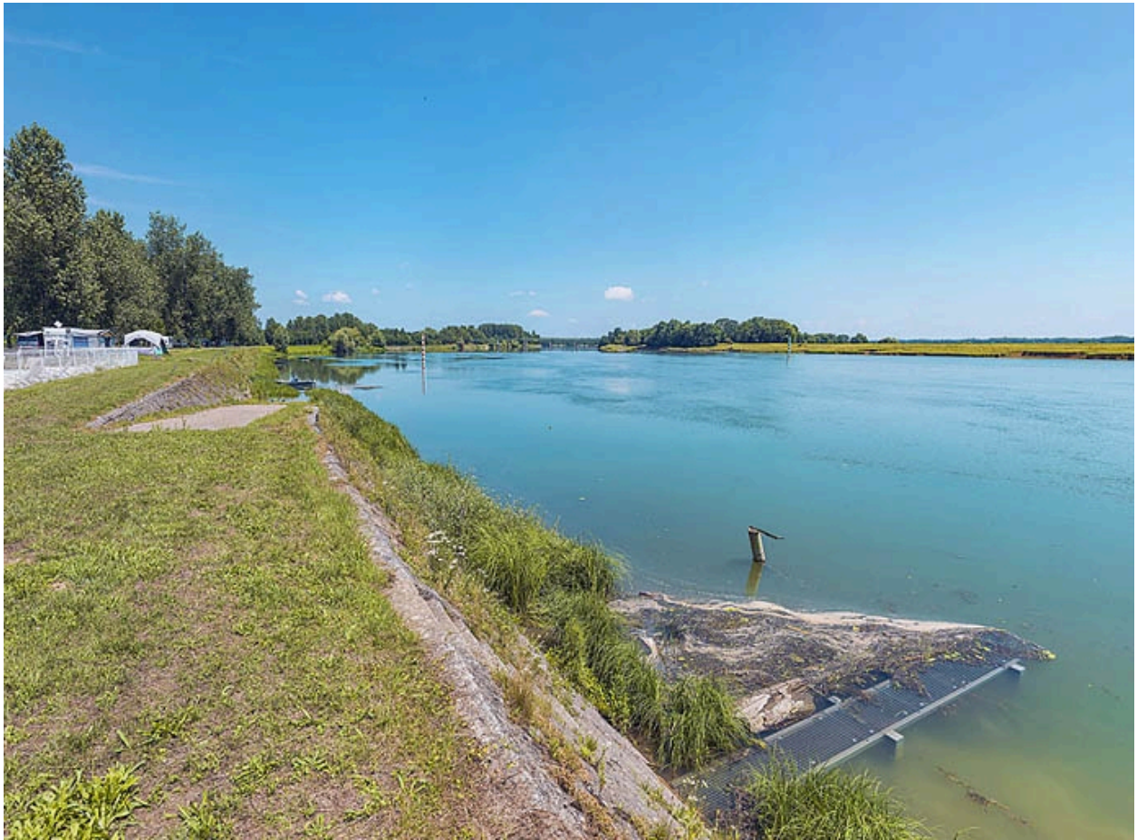
Rampe, perrés et escalier du port d'Uchizy.
