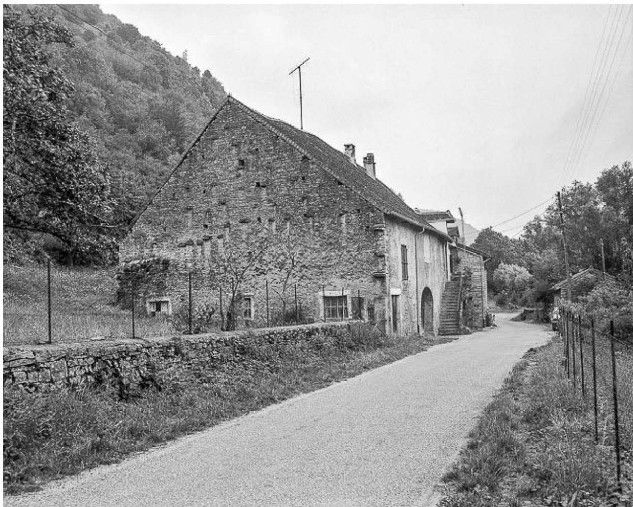
Maison de vigneron située à Vaux-sous-Bornay.
