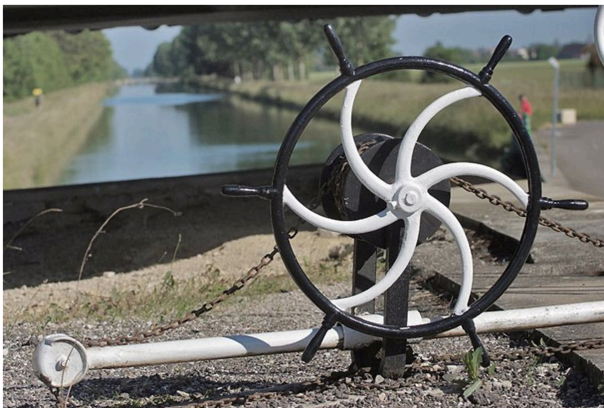
Mécanisme de porte.
