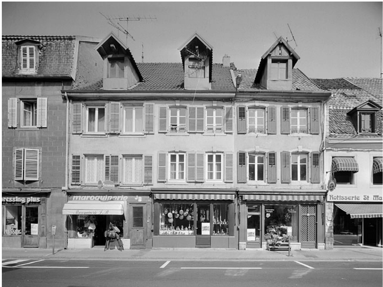
Façade sur rue. Au centre, demeure qui formait avec elle une maison double.
