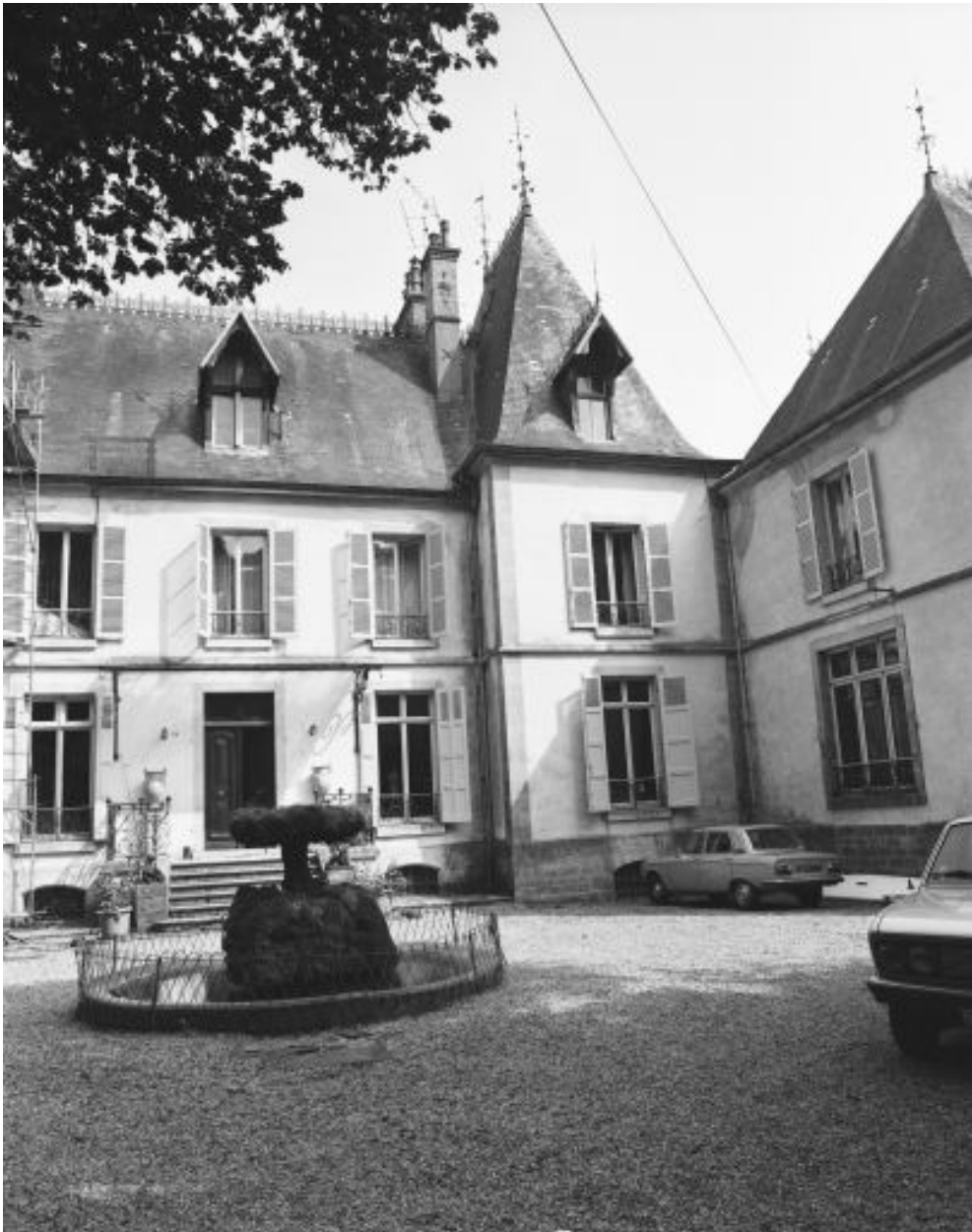
Vue partielle de la façade antérieure du château en 1980.
