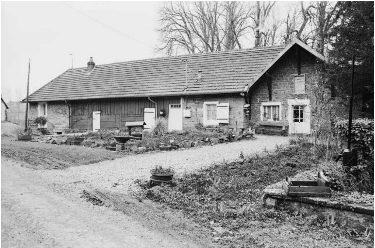
Façade antérieure d'un logement ouvrier.
