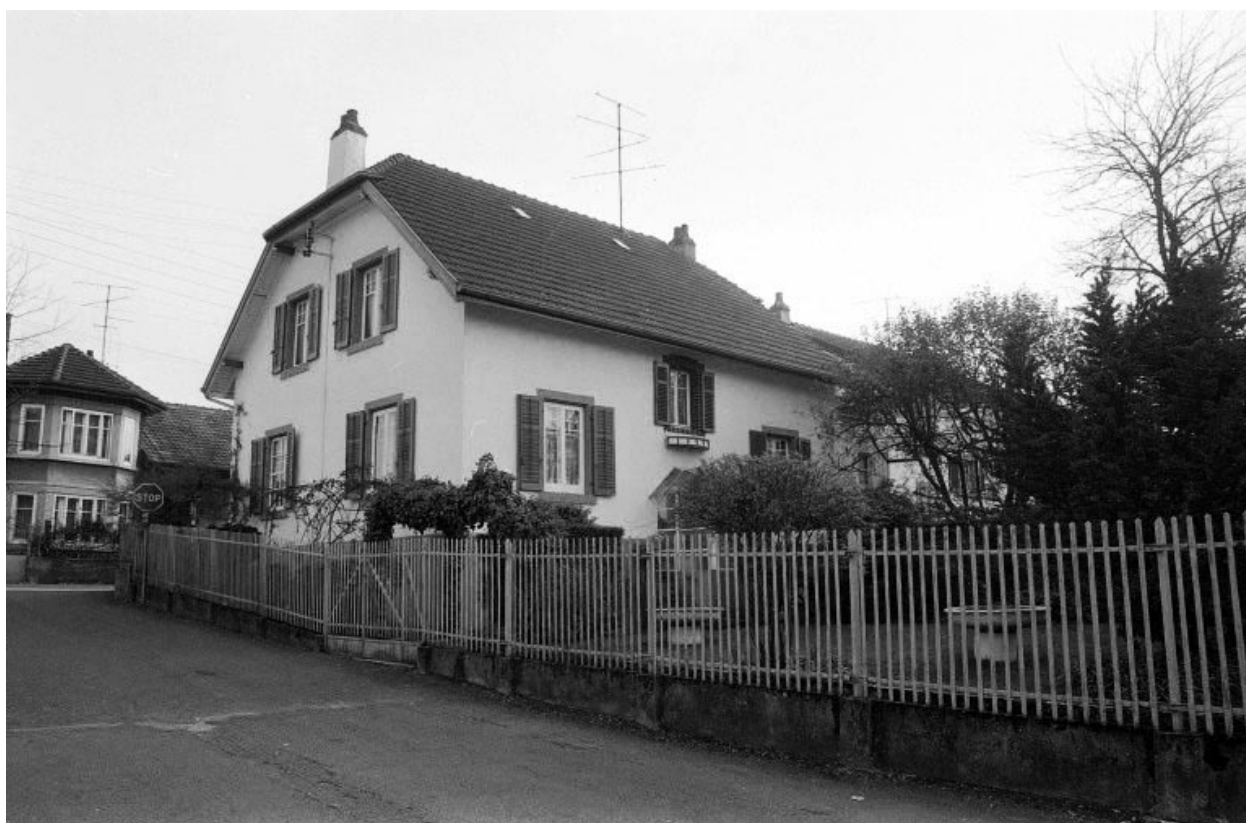
Façades postérieure et latérale droite.
