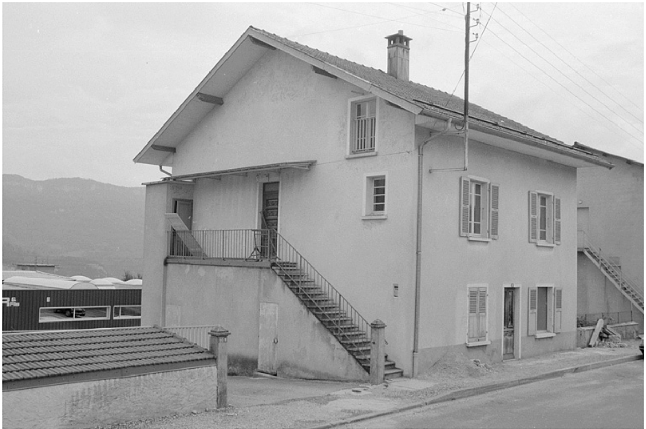
Magasin industriel (ancien logement) à l'entrée de l'usine.
