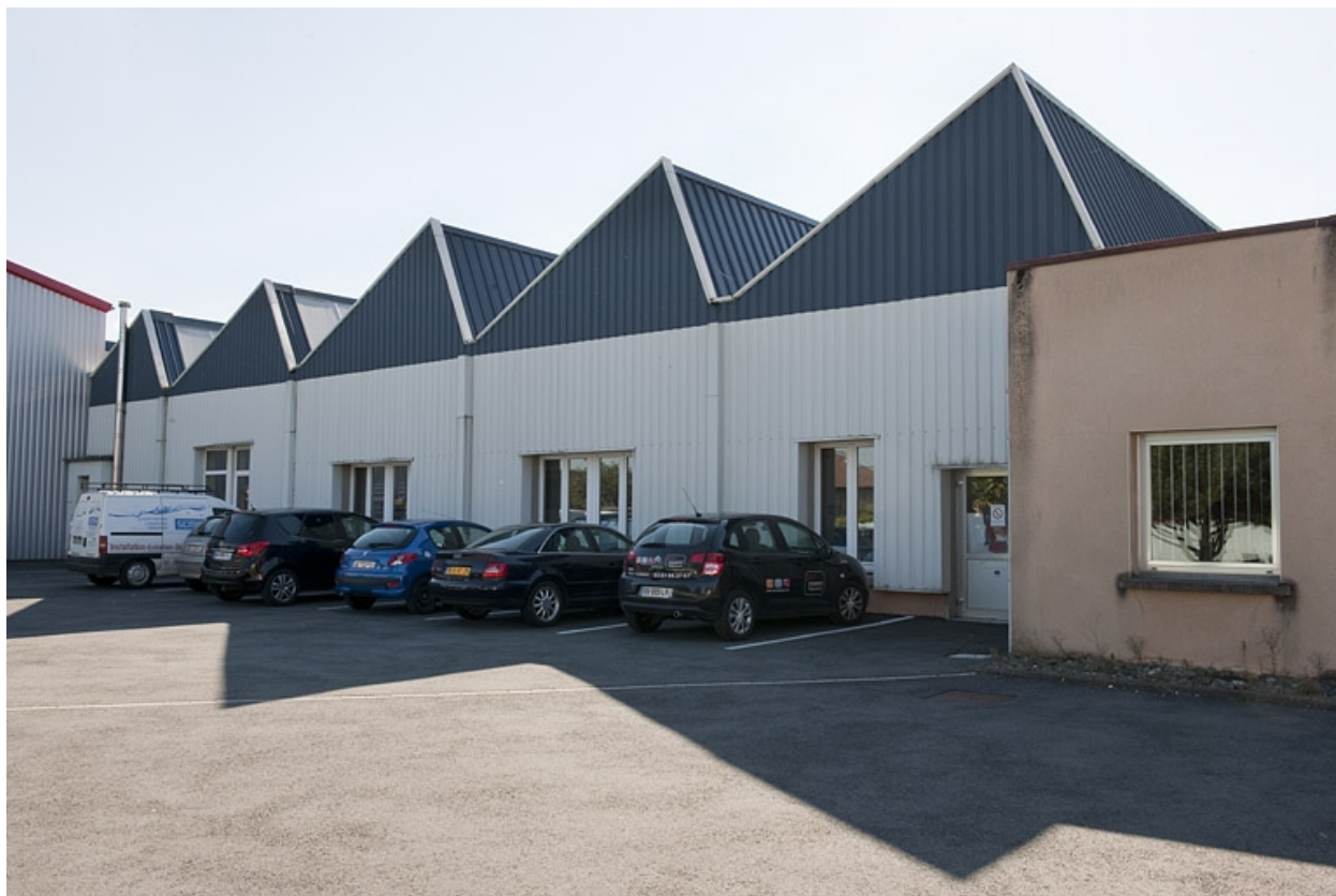
Bardage de la façade nord.
