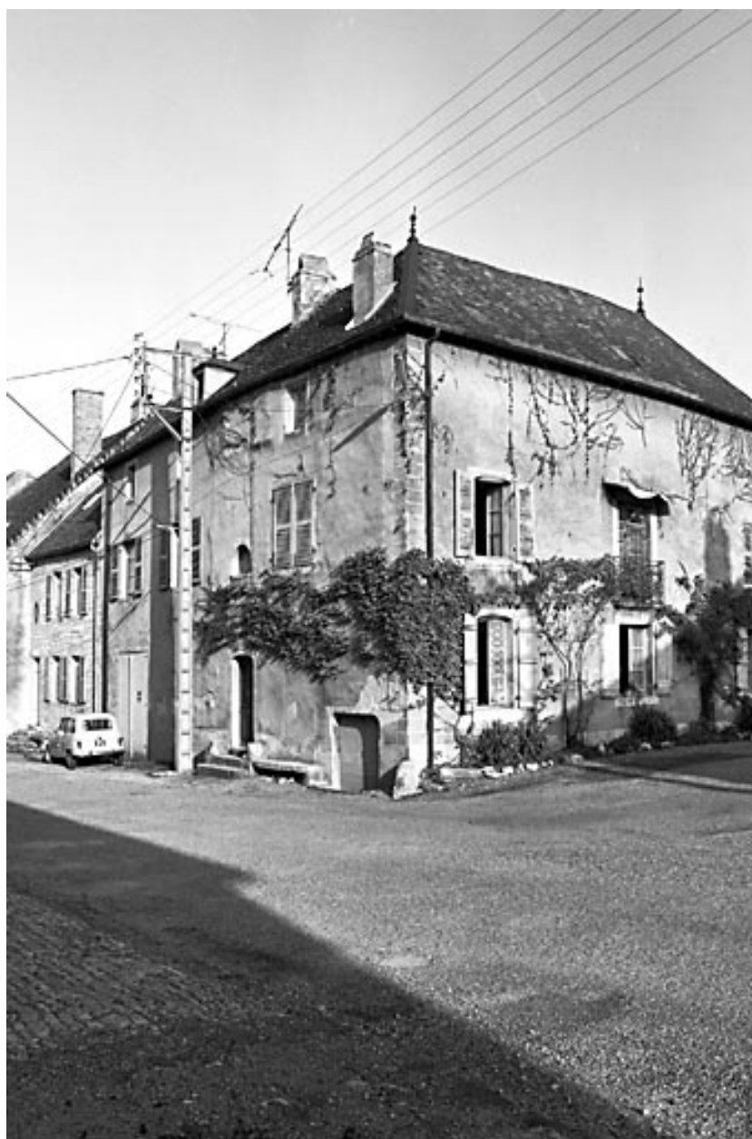
Façades antérieure et latérale droite.
