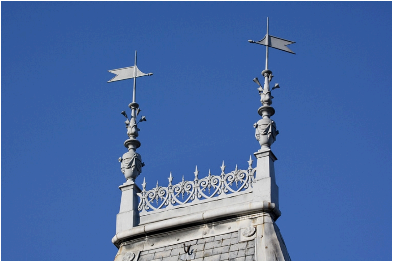
Détail des deux épis de faîtage sur la tourelle de l'escalier.
