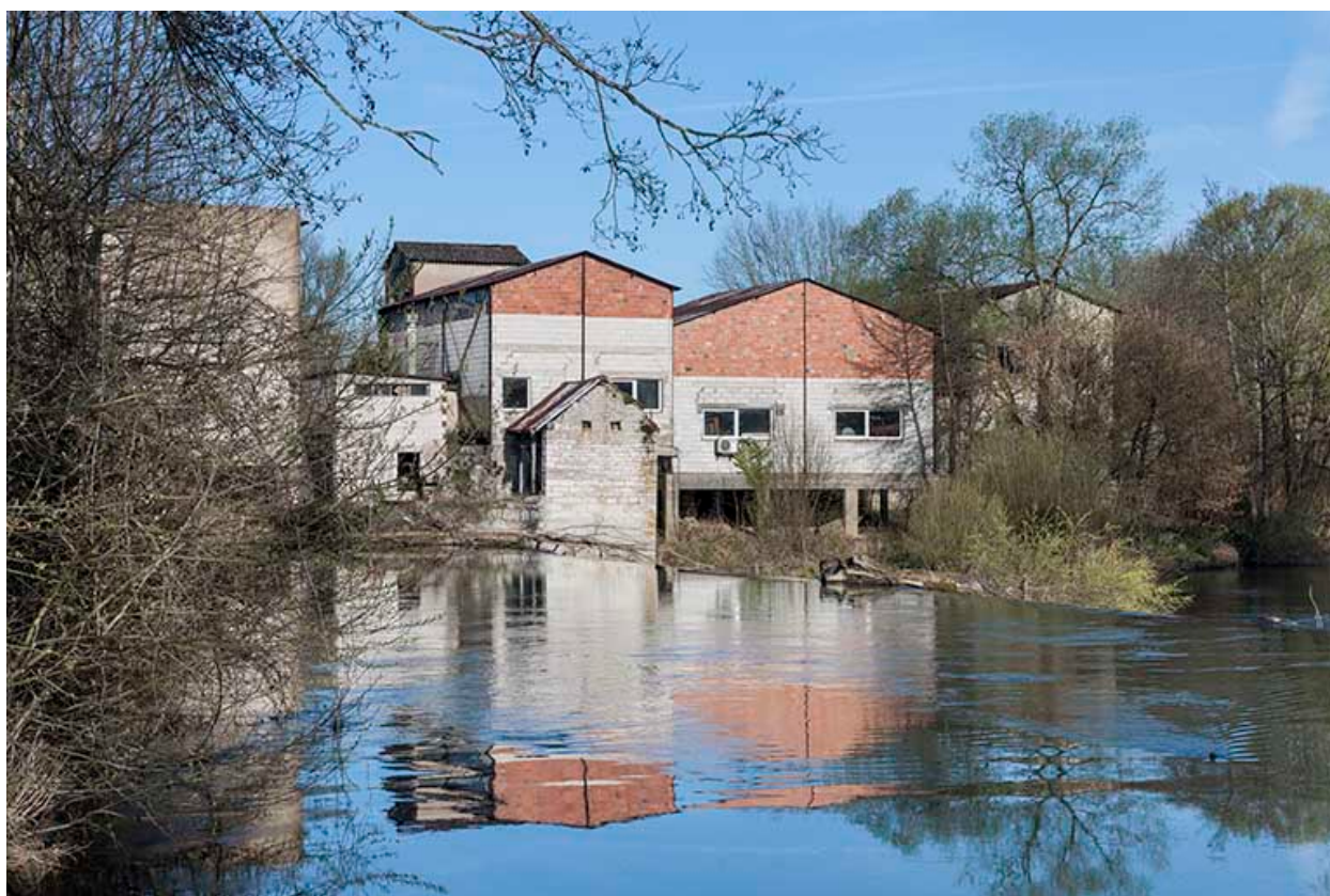
Vue d'ensemble depuis l'amont du barrage.
