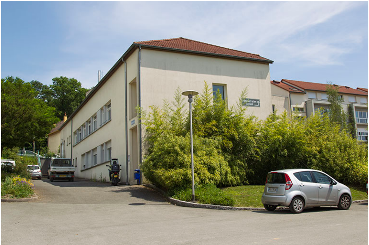
Angle nord-ouest de l'administration et des logements.
