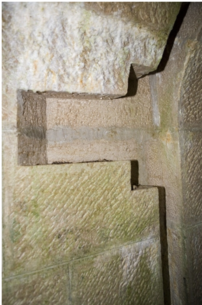
Chambres de mine sud-ouest : encoche creusée dans le mur.
