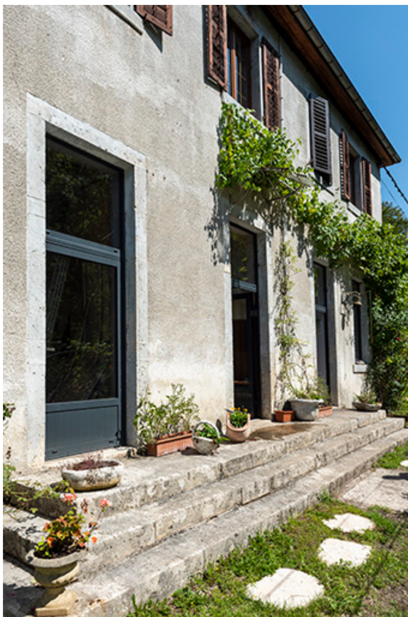
Façade antérieure et perron, vus en enfilade.
