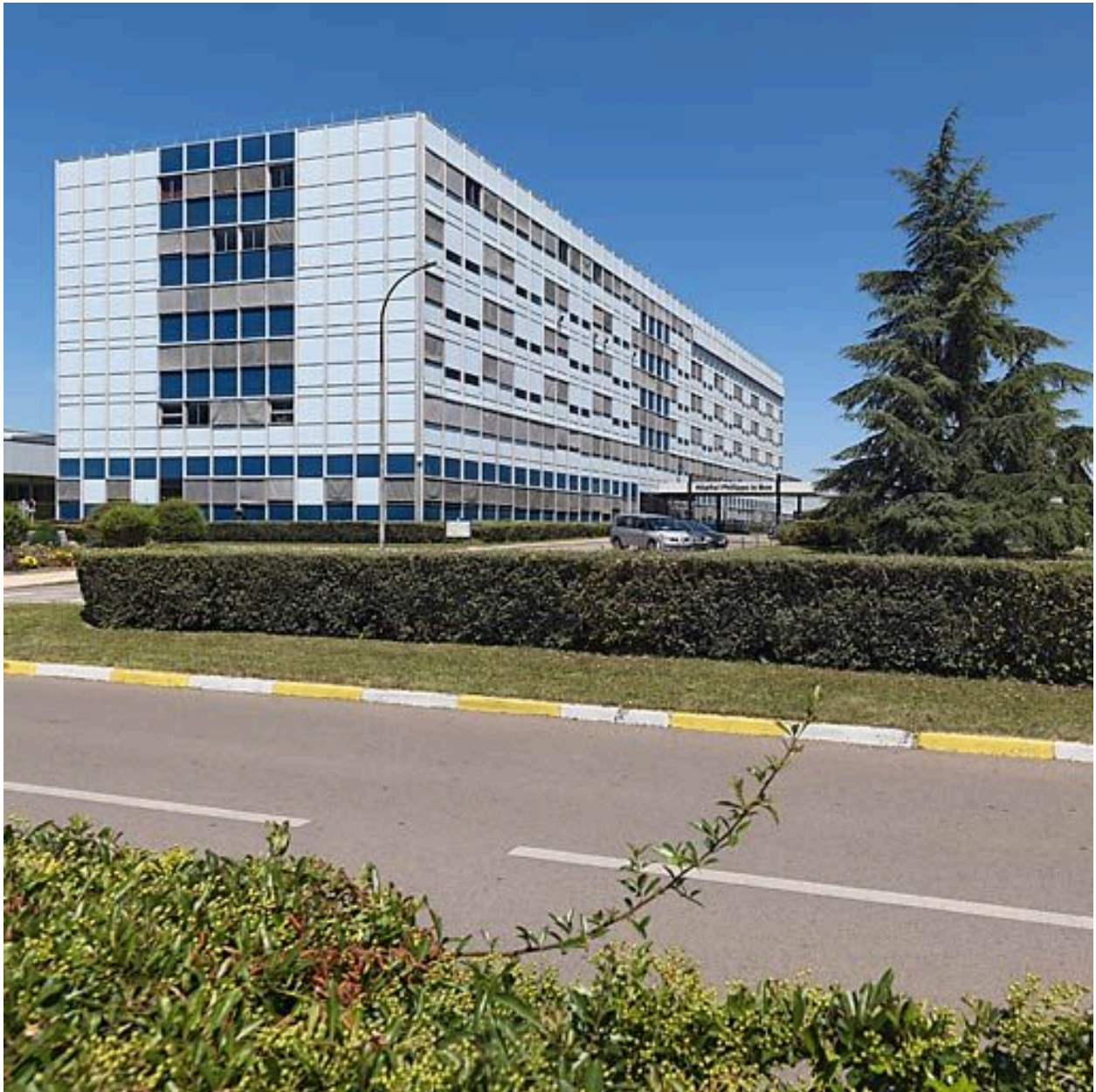
Bâtiment principal, vue d'ensemble de trois-quarts.
