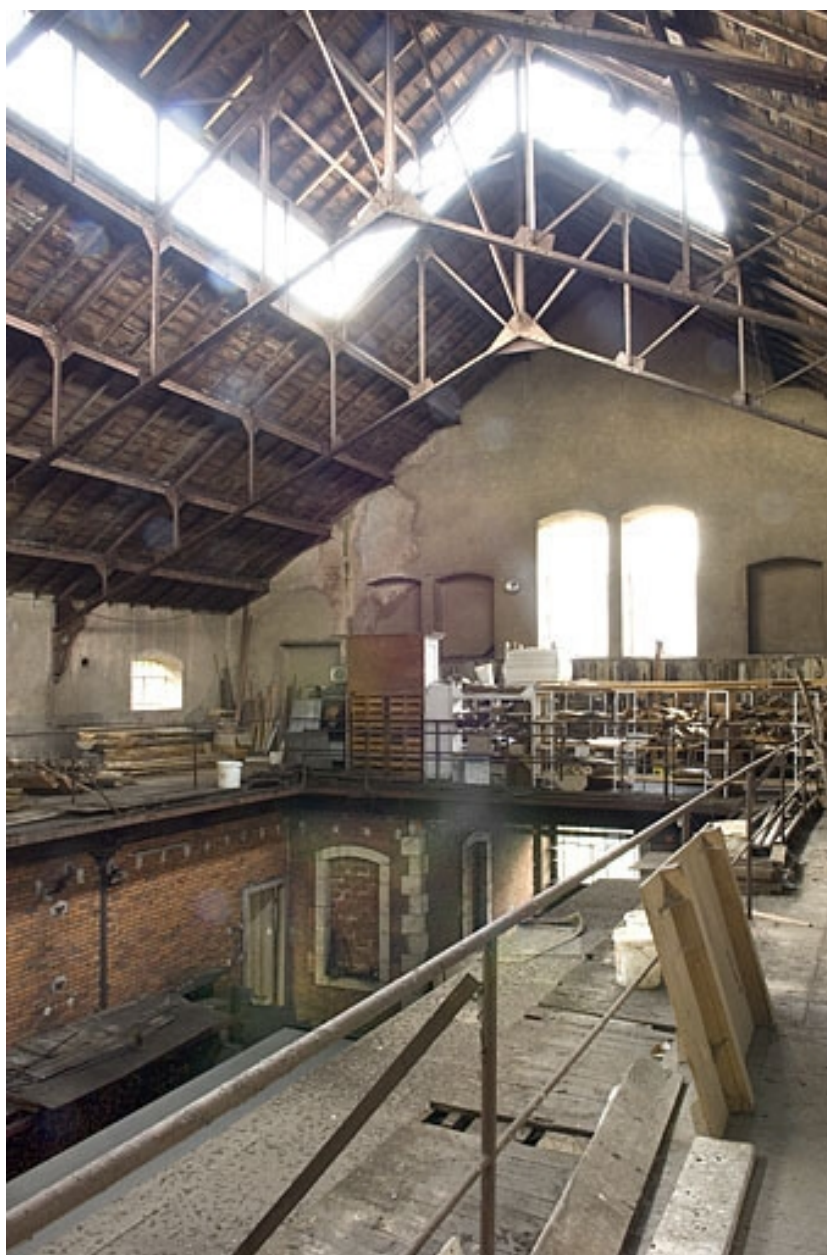
Disposition intérieure. Vue d'ensemble.
