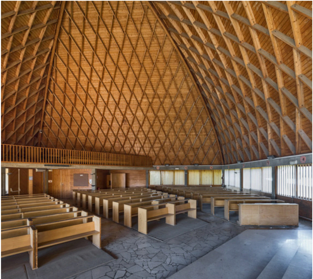
Nef. Vue en direction du nord-ouest.
