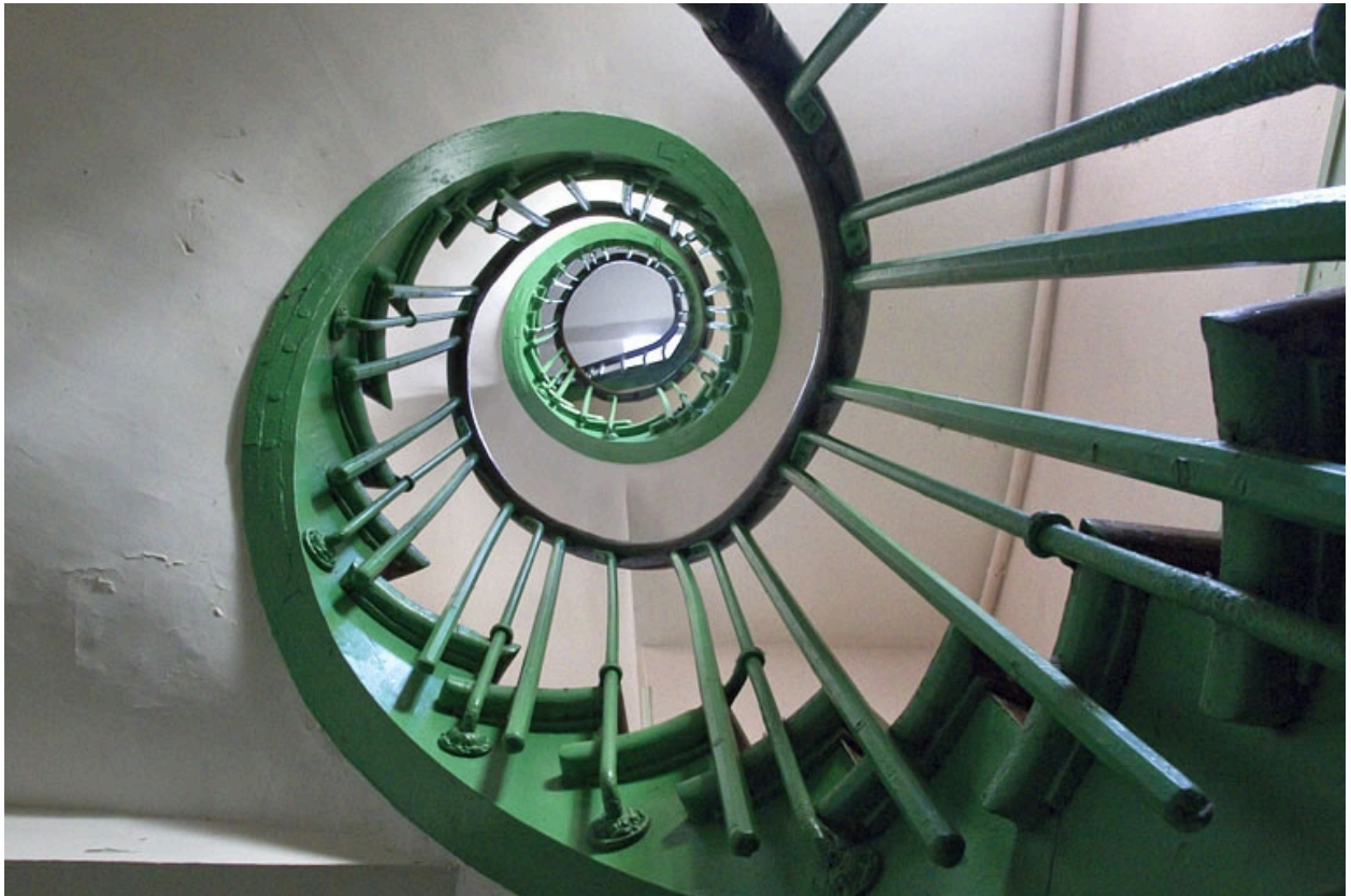
Deuxième logis secondaire : détail de l'escalier, en contre-plongée.
