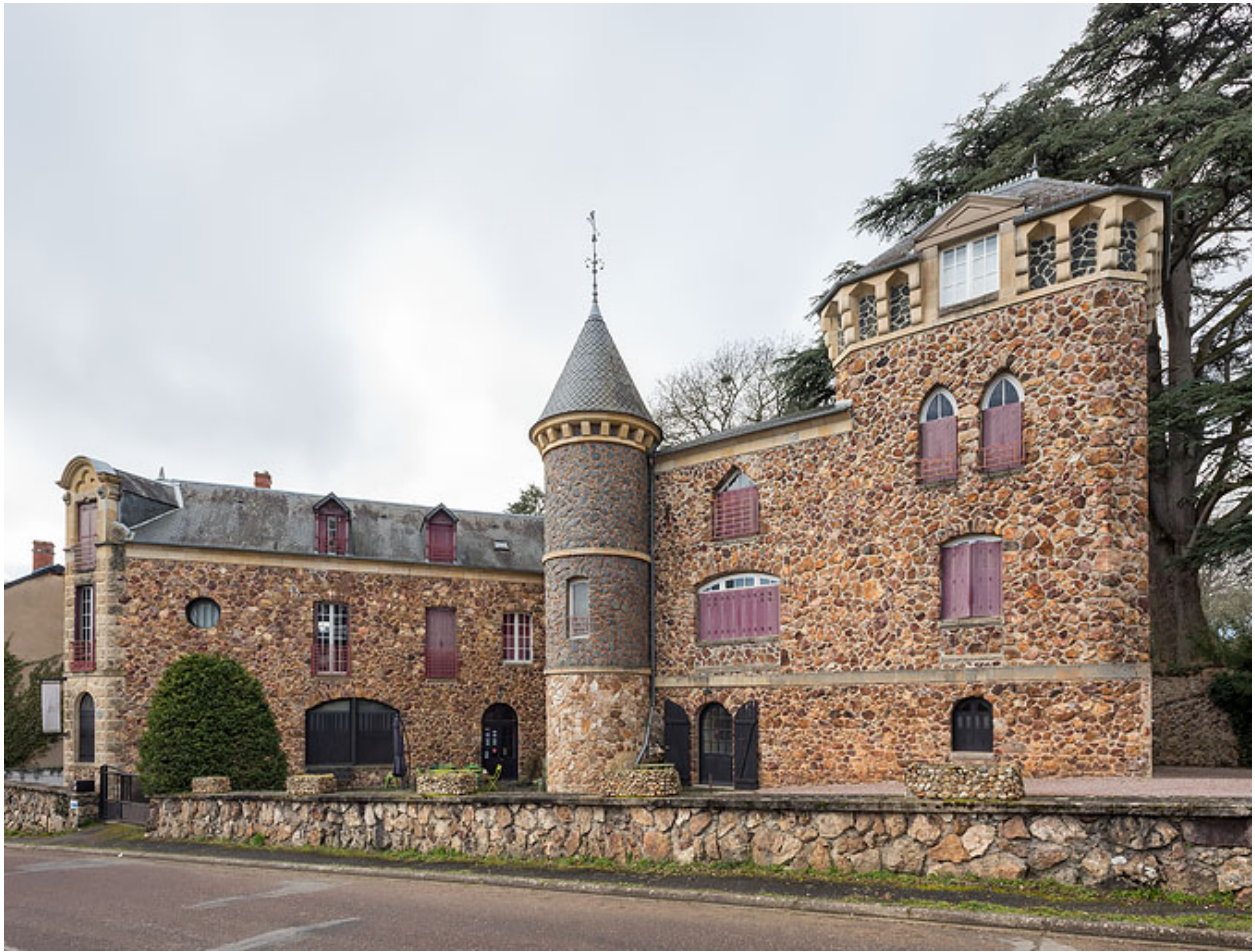
Façade sur la rue de L'Hâte.
