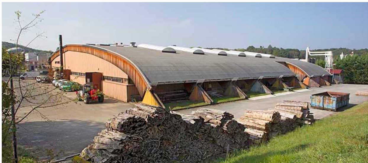
Atelier : couverture avec charpente.
