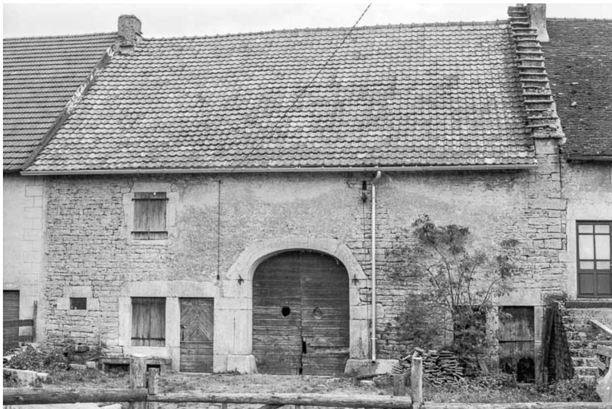
Façade antérieure : vue rapprochée.
