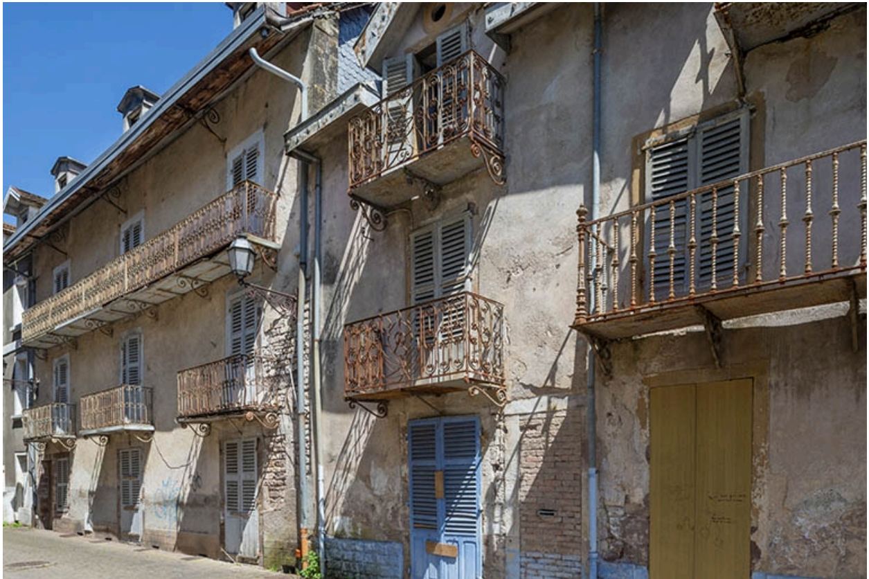
Balcons de la rue de la Fosse Pageot (actuelle allée des Romains).
