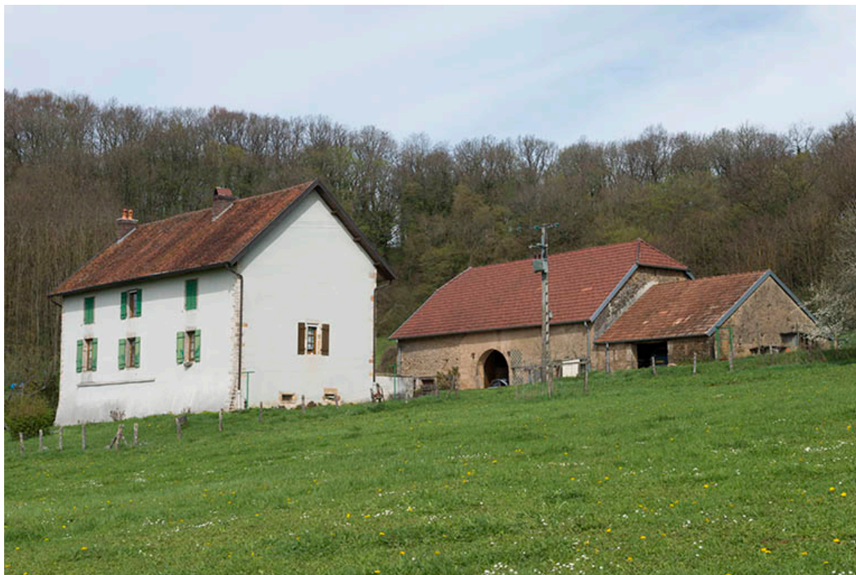
Vue générale des bâtiments composant le site.
