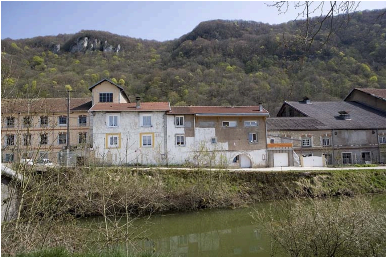
Façade ouest de l'usine. Partie centrale.
