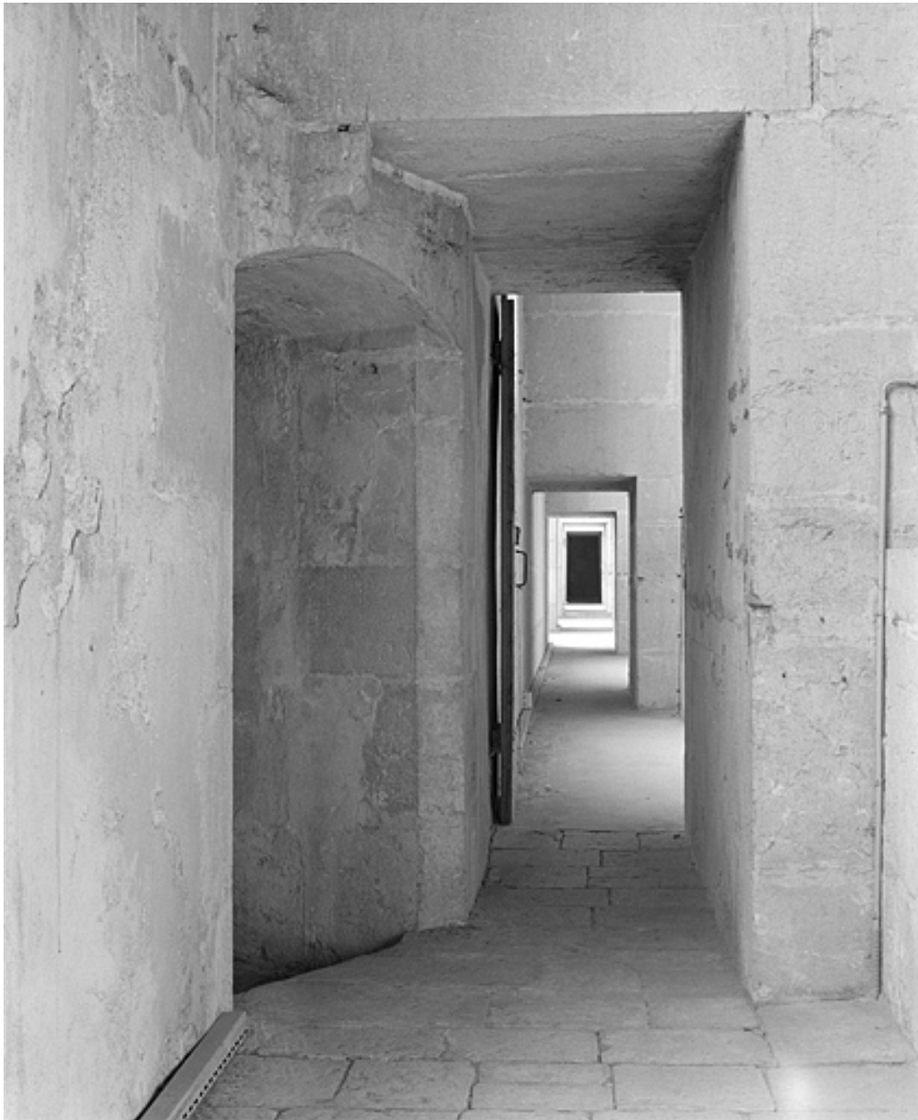
Passage établi au droit de la pile 6S dans la coursière du collatéral sud.
