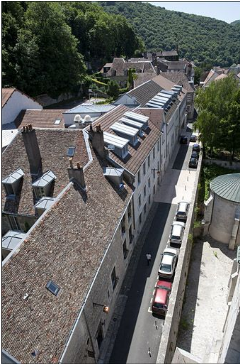
Vue de l'alignement sur rue du logis, depuis le clocher de la cathédrale.
