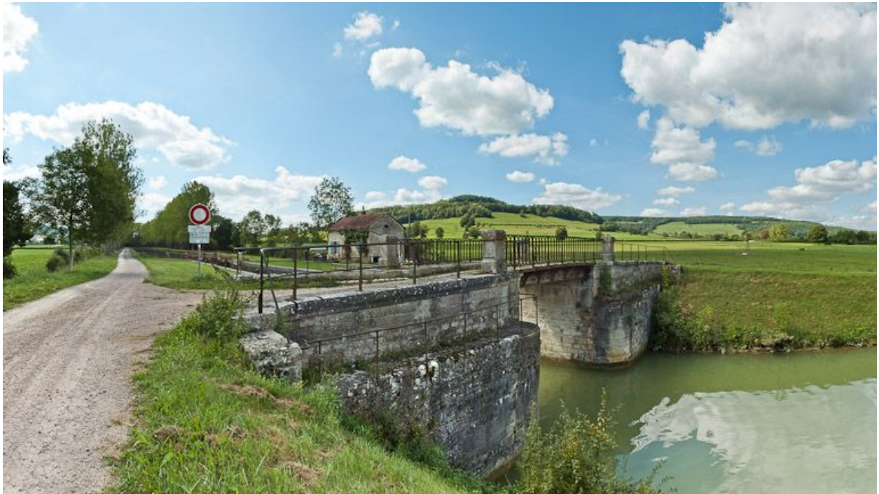
Vue du pont.
