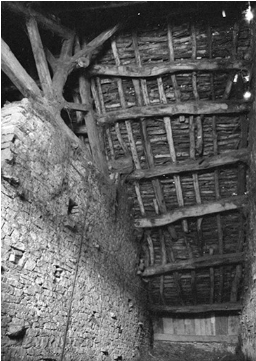
Ferme cadastrée 1960 B 109, située au lieudit La Peyrouse : charpente de toit de laves.
