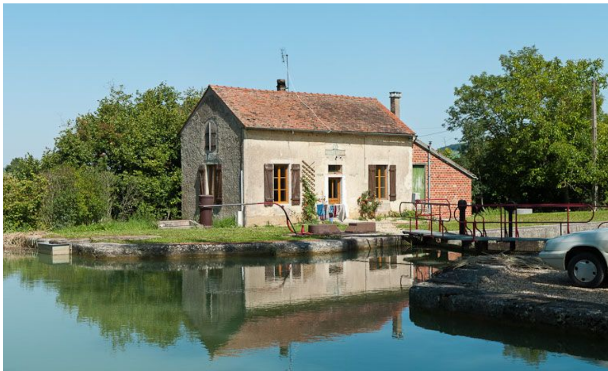
Vue du site d'écluse depuis l'amont.
