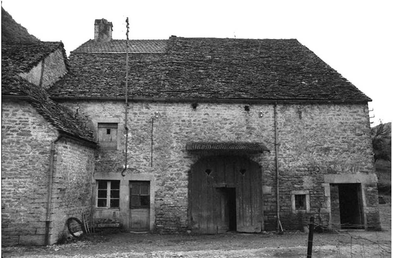
Ferme cadastrée 1960 C 543 , située au lieudit Cour froide : partie habitation.
