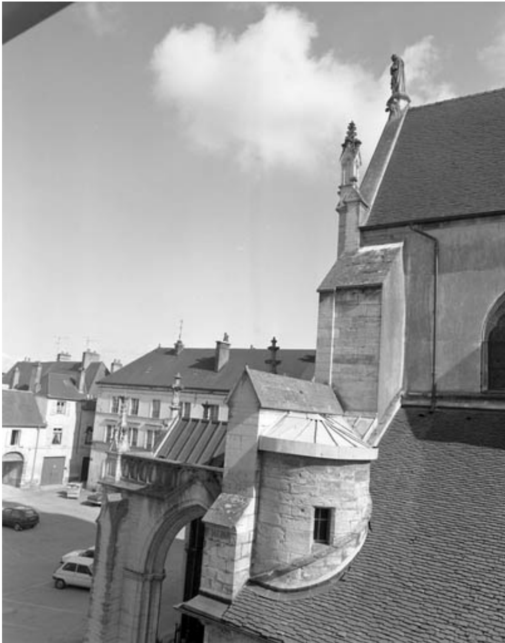
Façade occidentale : contreforts et tourelle d'escalier au nord-ouest.
