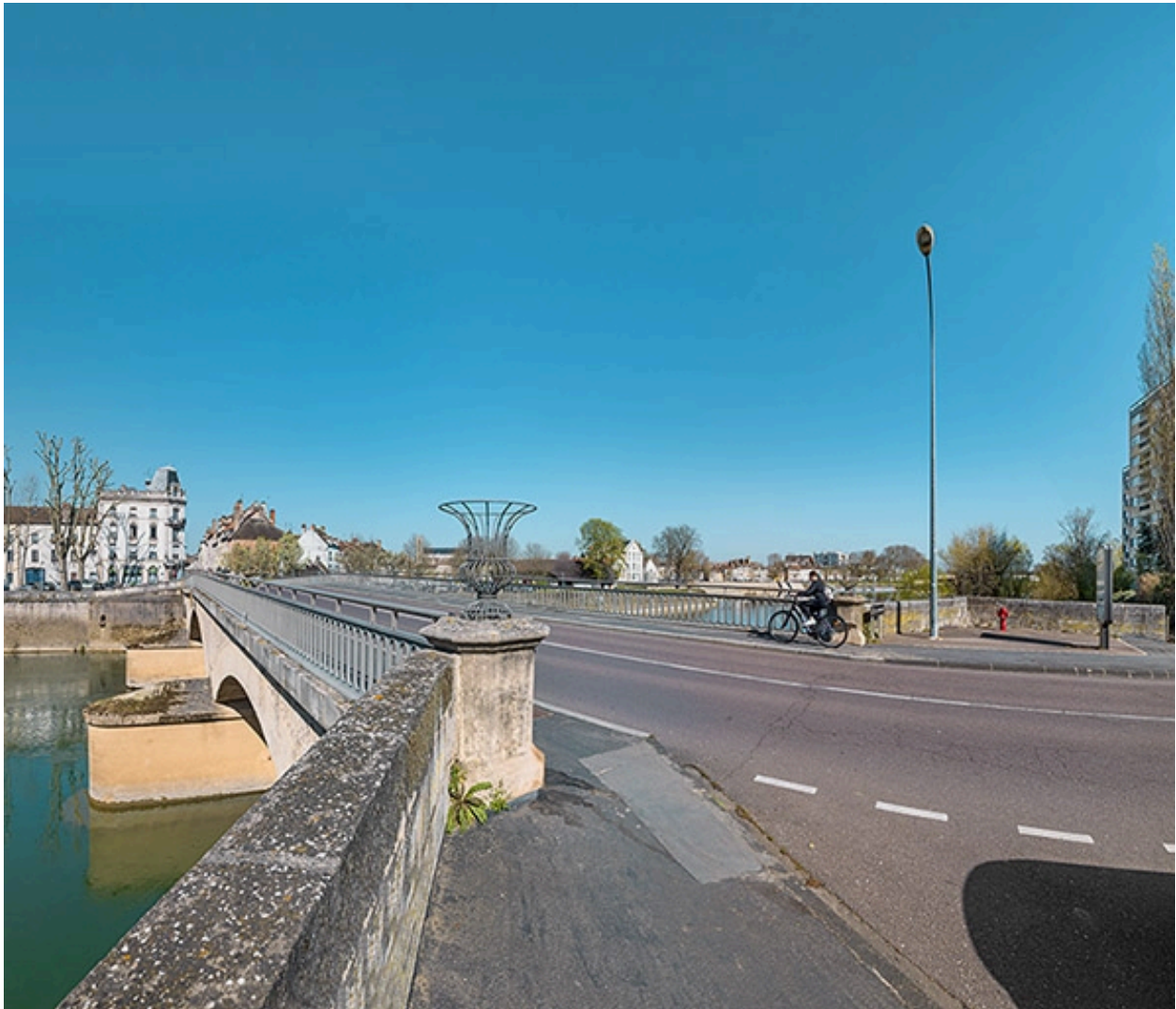
Vue d'ensemble du pont depuis la chaussée.
