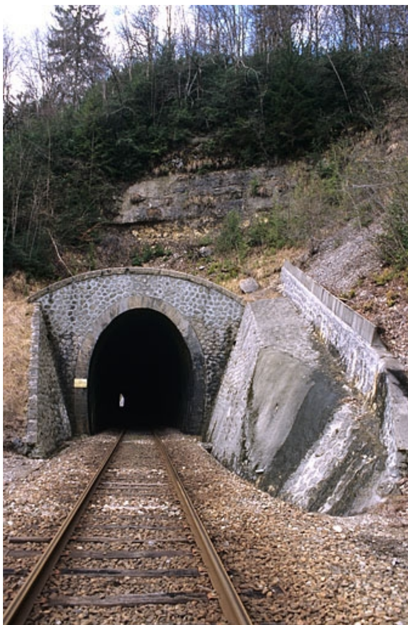
Tunnel des Frettes : tête côté Andelot-en-Montagne (nord).
