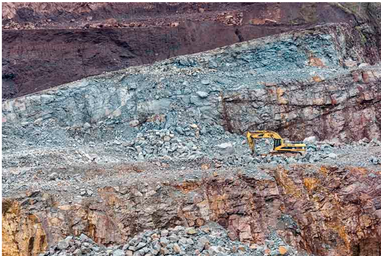
Carrière : front d'exploitation et pelle mécanique.
