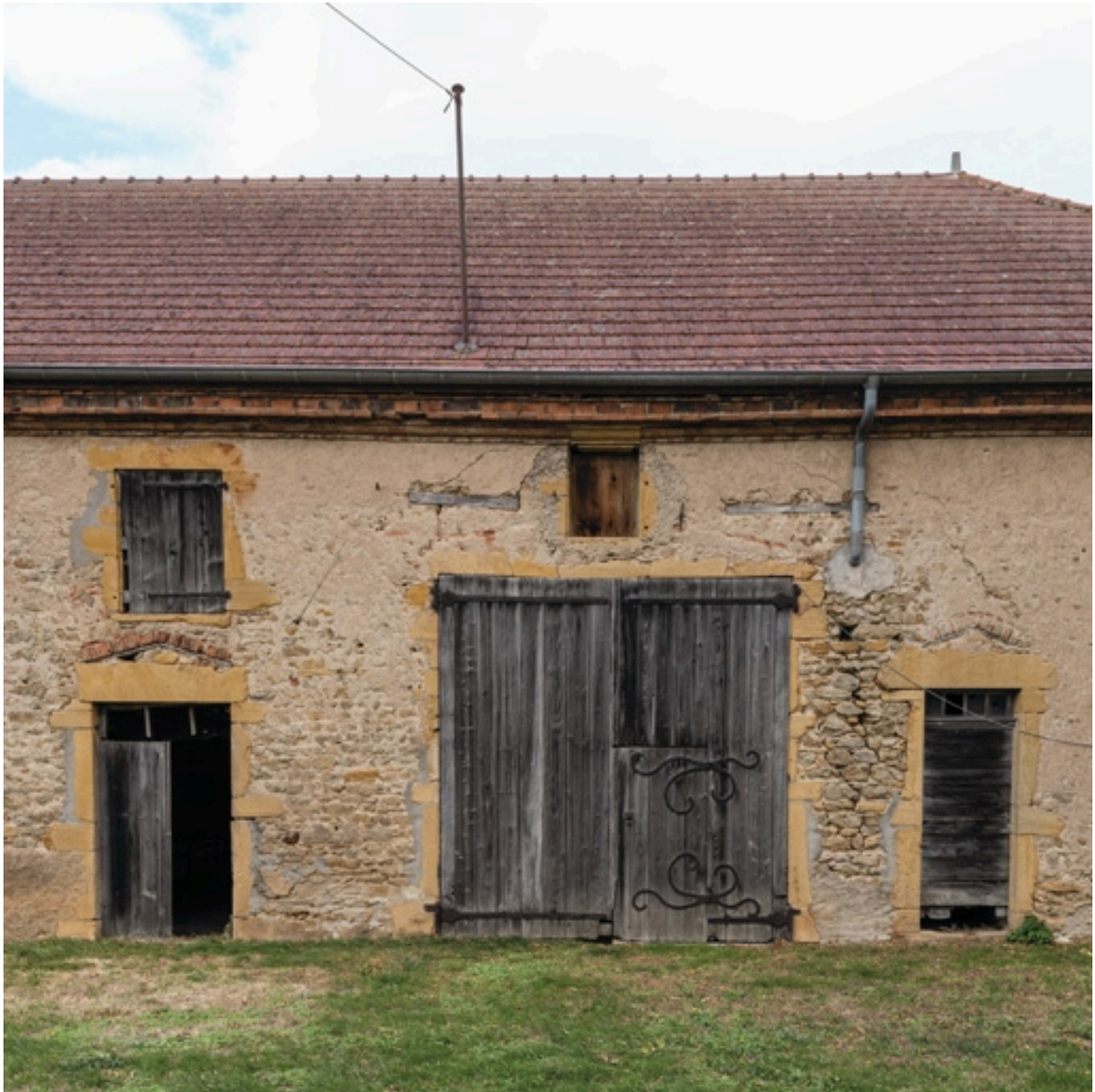
Détail de la façade sud-ouest de la grange, du côté du château
