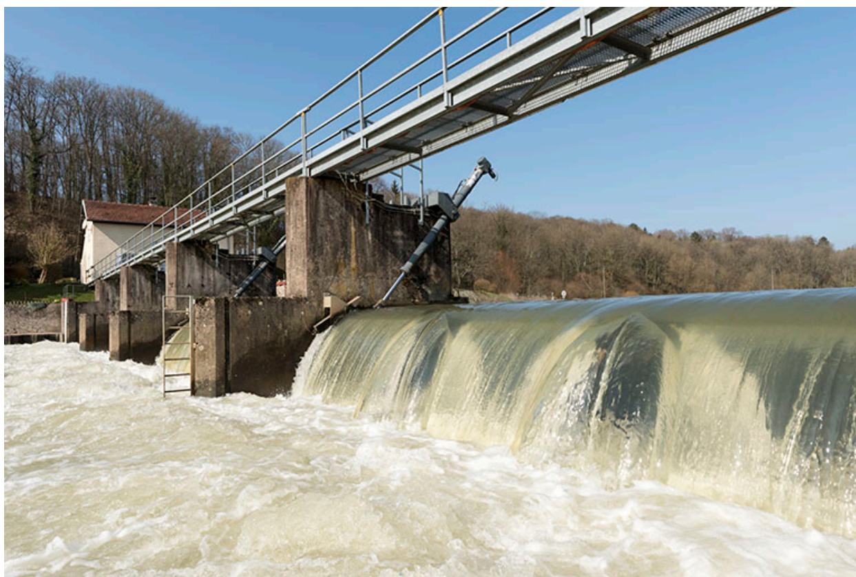
La passerelle du barrage.
